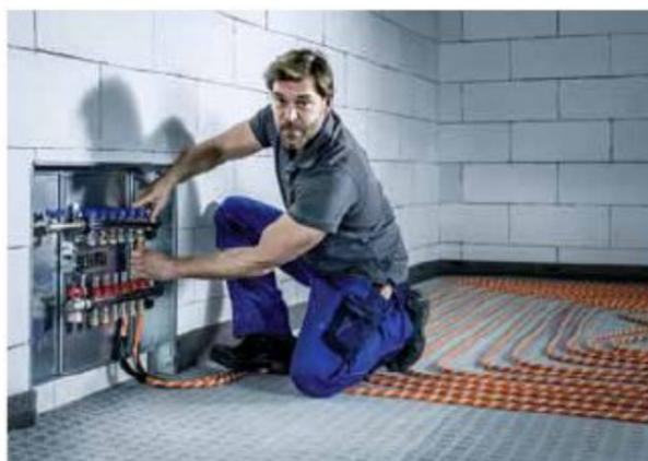
collettore in modo pratico e veloce mediante l'utilizzo di un attrezzo contenuto nella confezione. Compatibili con i tubi Rautherm Speed 16 x 1,5 e Rautherm Speed K 16 x 1,5, i nuovi collettori Rehau sono dotati di misuratore di portata 0-5 l/min per ogni circuito, in mandata, e di valvole di intercettazione incorporate predisposte per il comando elettrotermico, in ritorno, e presentano ru-
